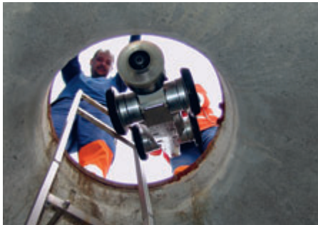
Der Kugelbildscanner wird in den Schacht eingesetzt.
